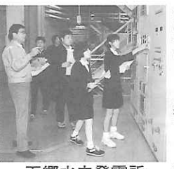
下郷水力発電所
