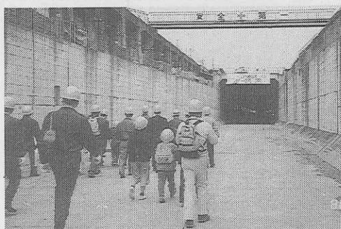
トンネル見学会は秋葉原口から入坑
